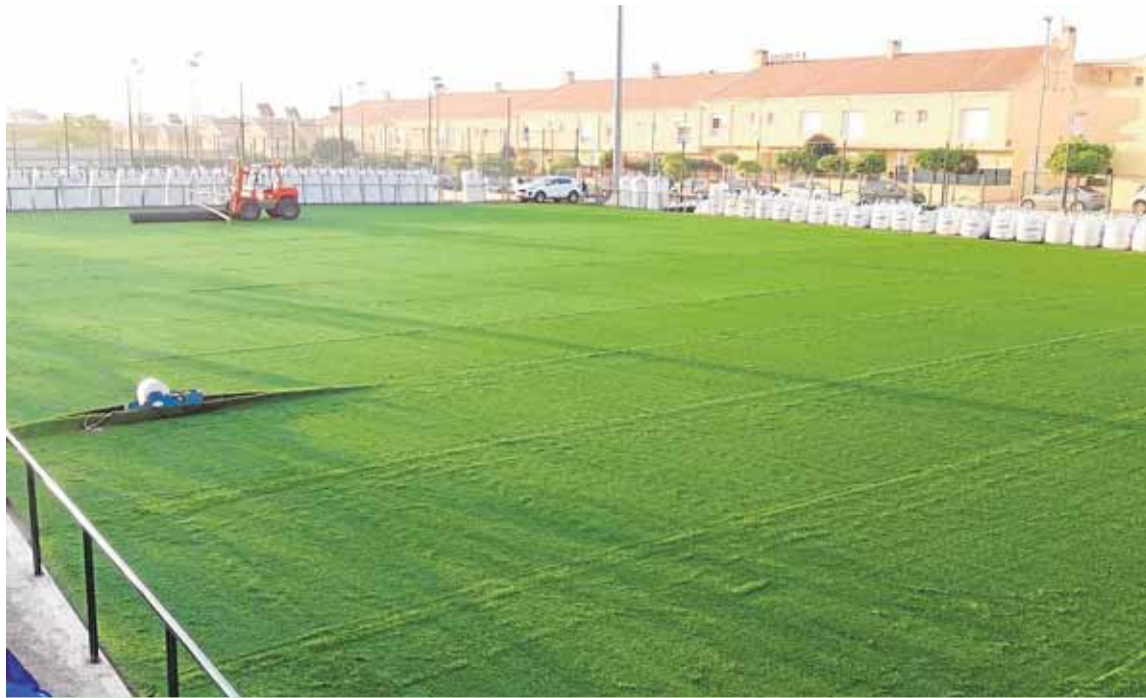
Instalación de césped artificial en Guadalupe.
