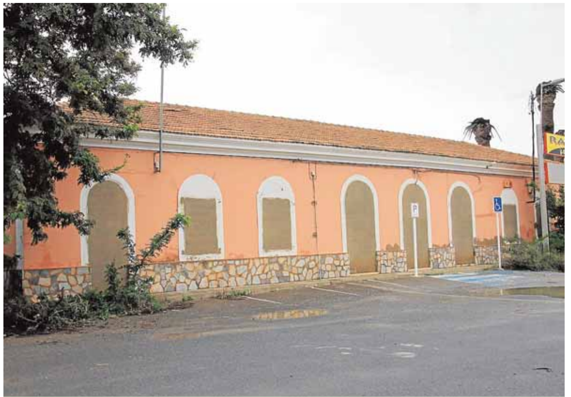
Antigua estación de ferrocarril, propiedad de Adif. LV
