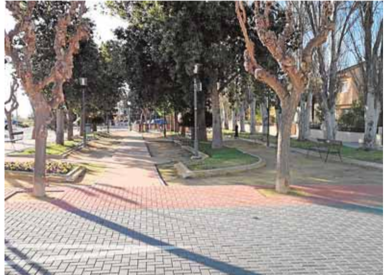
Mejora de la calzada en calle Iglesia. Miguel Ángel Noguera
